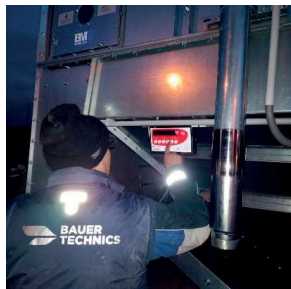
Montáž hladinových čidel, tenzometrů, a uzemnění sil
